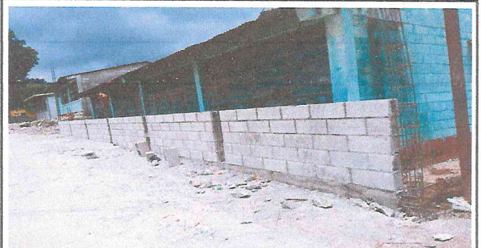
Foto 4: Pared de lado izquierdo a la mitad de proceso.
