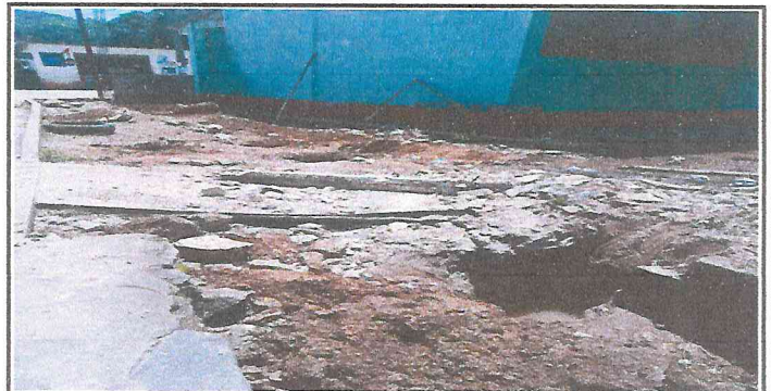
Foto 6: Fundición lista para levantado de pared.
