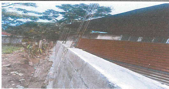
Foto 5: Pared lado derecho a mitad de construcción.
