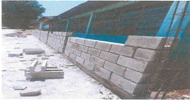
Foto1: aquí muestra como el trabajo avanza, esta es la pared del lado izquierdo del terreno de la escuela donde esta en proceso de construcción
